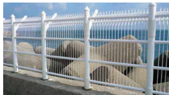
▲高波浪対策用空港フェンス
