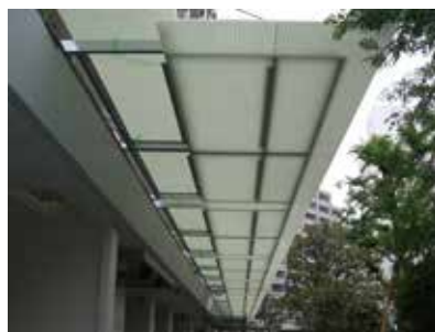
落下防止庇 (FRP グレーチング)
