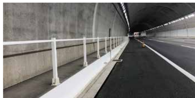
▲監視員通路手摺
