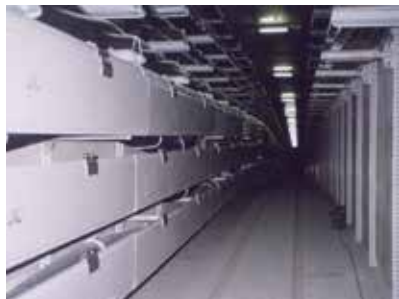
電力ケーブル防護板 (FRP 引抜成形品)
