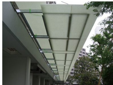
落下防止庇 (FRP グレーチング)
