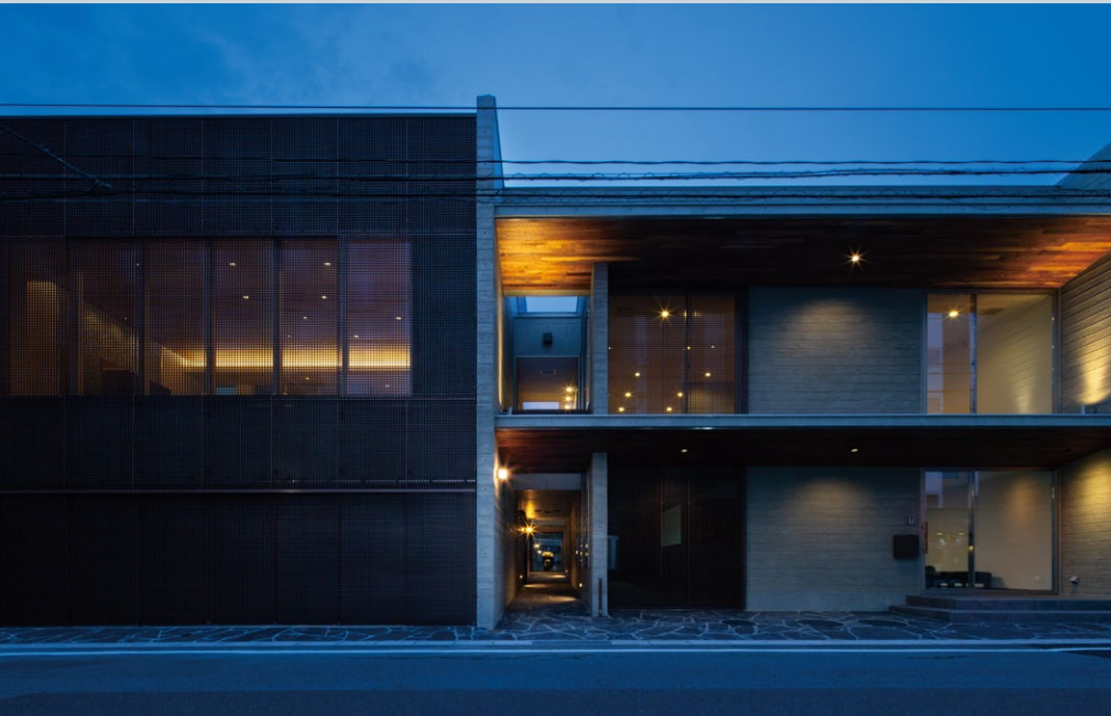
GS4025エイジング塗装（特注品） 視線のコントロールや防犯性を担保し、大きな面を 構成することで建物のファサードの意匠性を高めた
