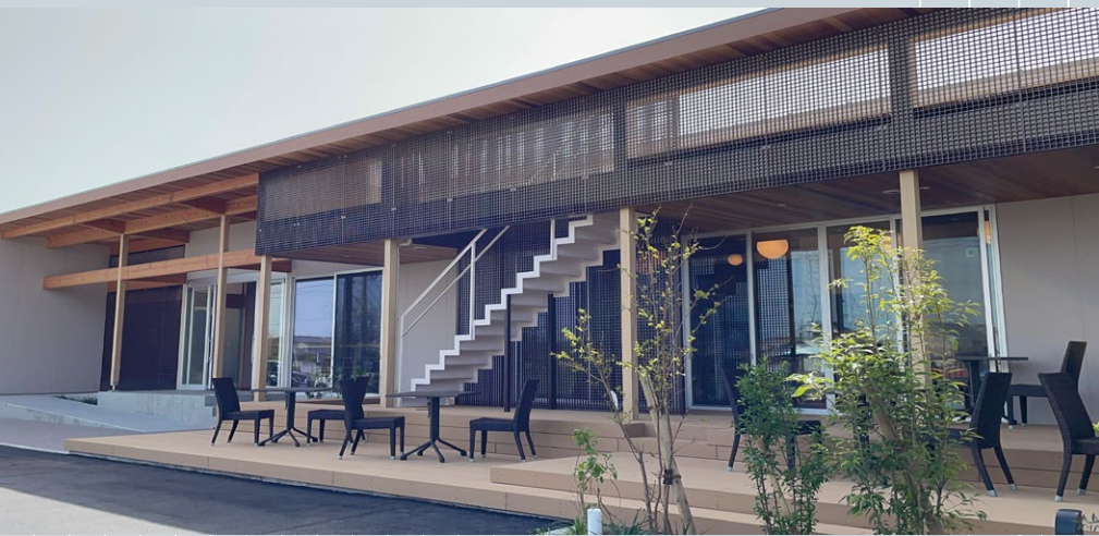
GS4040 エイジング塗装（特注品） 転落防止手摺に意匠性を持たせ屋上テラスへ 風が通るゆるやかな間仕切り
