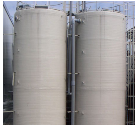
水槽 (FRPタンク)
