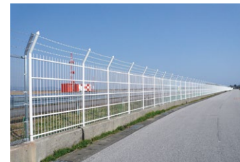
空港の飛行機侵入部で電波障害を避けるためのフェンス
