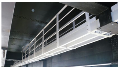
橋梁長寿命化の点検に欠かせない軽量で腐食しない検査路
