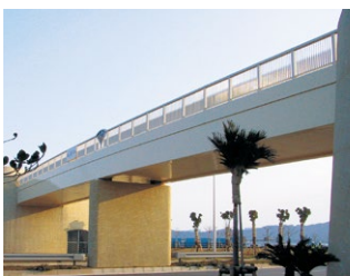
海洋環境での全FRP歩道橋引抜成形、ハンドレイアップなどFRP成形法の組み合わせによって構築
