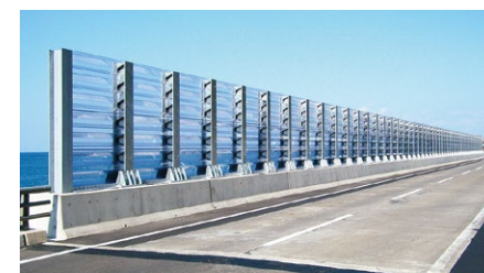
越波対策用ポリカーボネート製透光防波柵
