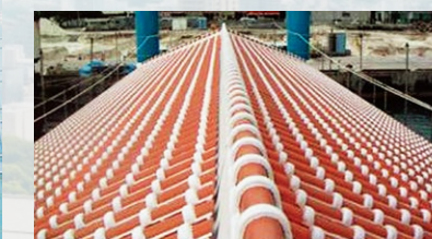
「瓦屋根」ハンドレイアップ成形品沖縄瓦の意匠性を取入れたFRP瓦屋根海洋環境下で使用
