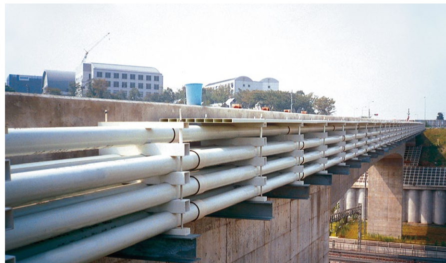
「情報BOX管路 (光ファイバー用)」引抜成形品プラアロイ®
