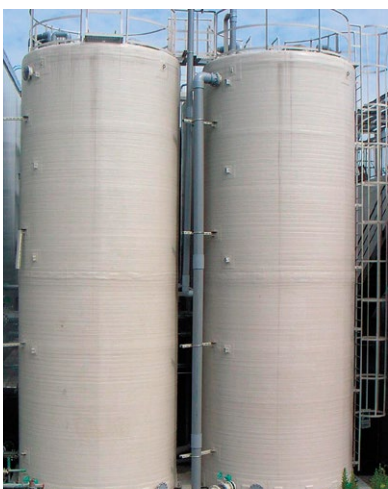
純水槽 (FRPタンク)
