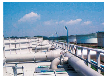
塔上送水配管 (FRPパイプ)
