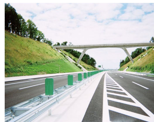
「眩光防止板」SMC成形品寒冷地所向け眩光防止板高強度、耐久性が高い
