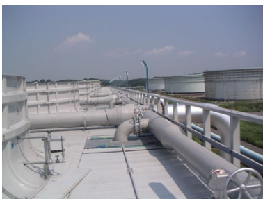
塔上送水配管
