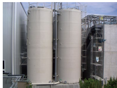
純水槽 (FRPタンク)
