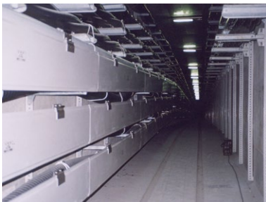
電力ケーブル防護板
